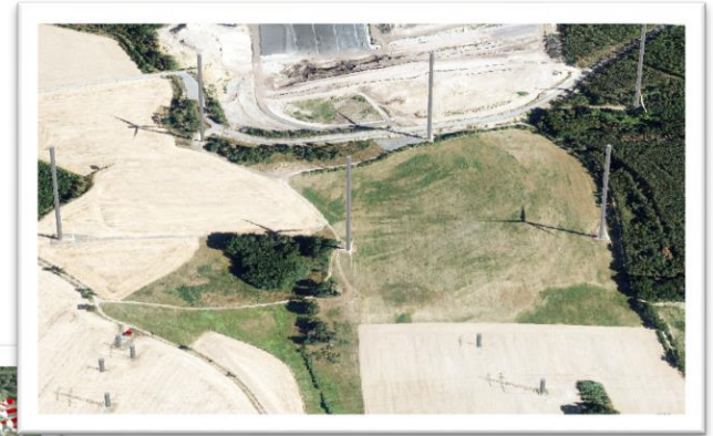
Windpark und Freileitungstrassen in der Nähe eines Tagebaus in Puschwitz
