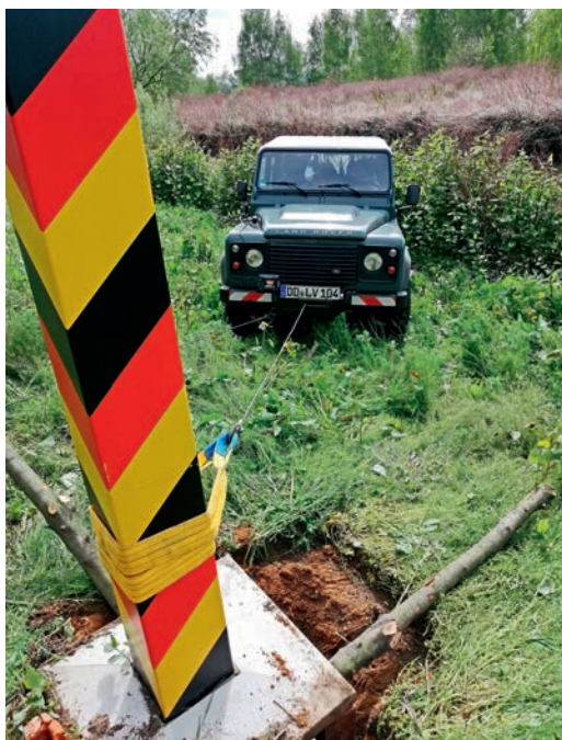
Setzen einer Grenzmarkierungssäule an der Neiße
