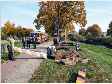
Die neue Grenzmarkierungssäule wird eingebracht
