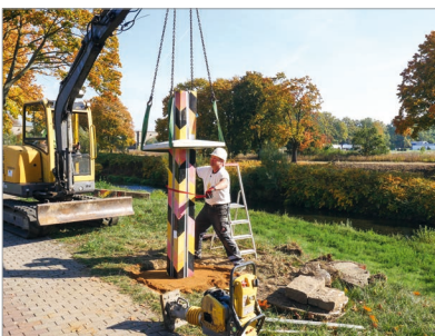
Die Betonmanschette gibt Stabilität
