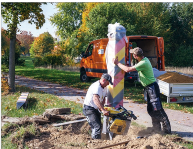
Der Boden wird verfestigt
