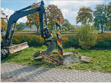
Die alte Grenzmarkierungssäule wird entfernt
