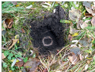
Dränrohr in 25 cm Tiefe
